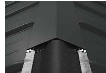
Abbildung 71 • Firstausbildung mit einfacher Firstkappe
