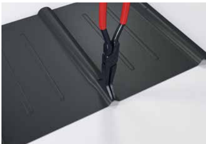
Abbildung 70 • Einfache Firstausbildung mit Einhängfalz – Besonderheit bei Dachplatten
