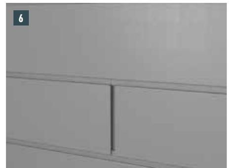
Nächstes PREFA Siding entsprechend Verlegerichtlinien mit Versatz montieren. (Mindestversatz: eine Baubreite)
