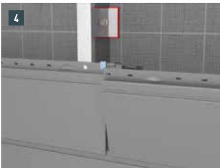
Nächstes PREFA Siding platzieren und die seitliche Endabkantung in die PREFA Fuge stecken.
