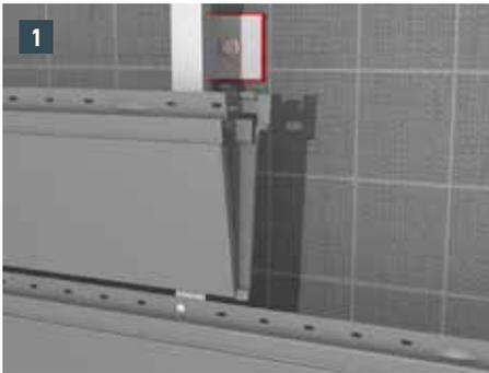
PREFA Fuge entsprechend Bild 1 in die Endabkantung des PREFA Sidings stecken.
