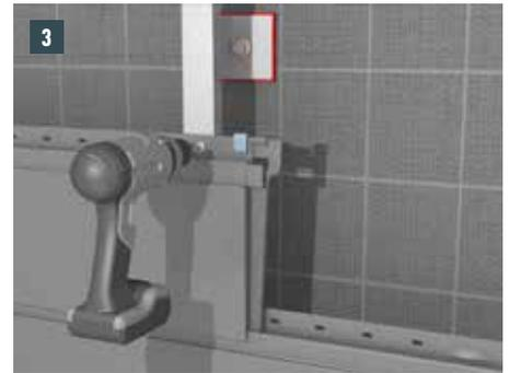
PREFA Siding mit vormontierter Fuge entsprechend Siding-Verlegerichtlinien montieren und an der Unterkonstruktion befestigen.
