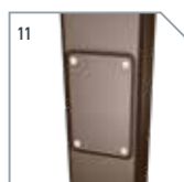
11 Hranatý svod s čistícím otvorem
